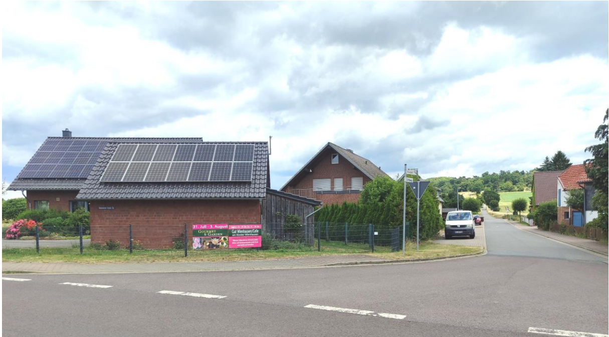
Abb. 5: Blick auf die Bebauung Ecke Driftweg/Hildesheimer Straße (planerzirkel 06/2025)
