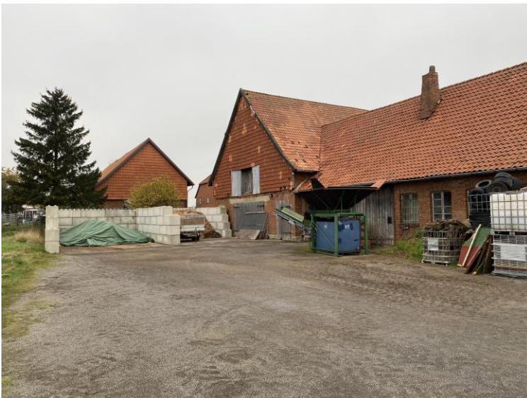
Abb. 4: Nördlicher Änderungsbereich mit ummauerten Lagerplätzen links im Bild (planerzirkel 11/2024)
