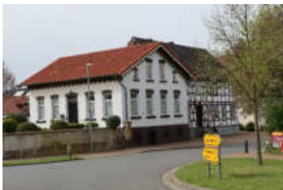
Ortsbildprägendes Wohnhaus mit Hohlpfanneneindeckung, Beispiel aus Haverlah
