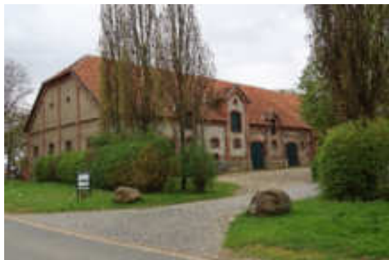
Verputzter Bruchsteinbau mit Ziegelgliederungen in Groß Heere
