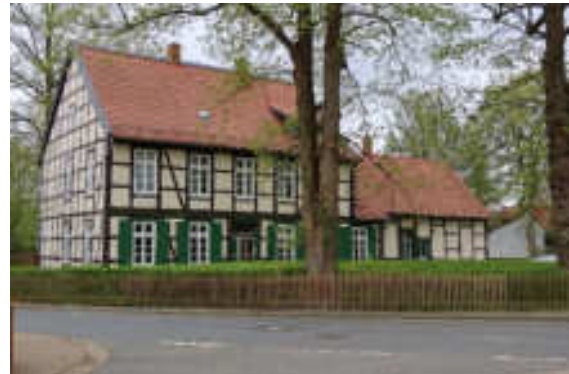
Neueingedecktes ortsbildprägendes ehem. Gr. Heerer Pfarrhaus mit heute angrenzendem kirchlichem Gemeindehaus
