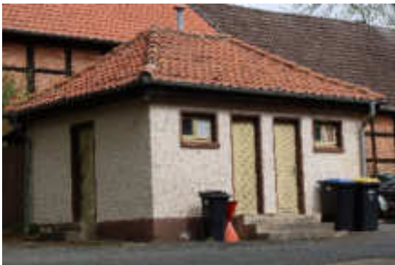
Auch diese Türen eines ehemaligen Toilettenhäuschen in Groß Elbe ist beispielgebend, erhaltungswürdig und darüber hinaus baukulturell bedeutsamer Zeitzeuge
