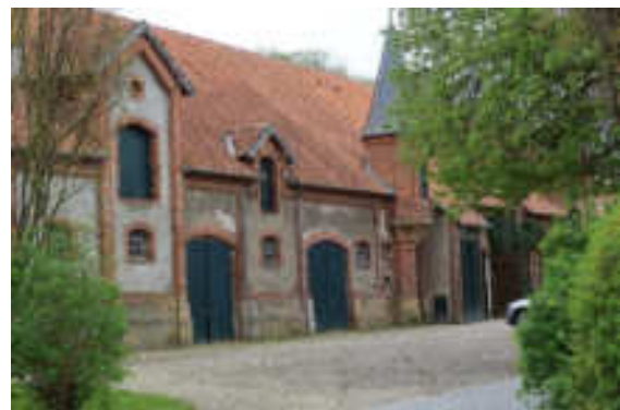
Weiteres Beispiel einer ortsbildprägenden Dacheindeckung auf Wirtschaftsgebäudekomplex in Groß Heere
