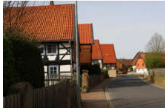
Dacheindeckungen mit Holzziegel an der Haverlaher Hauptstraße
