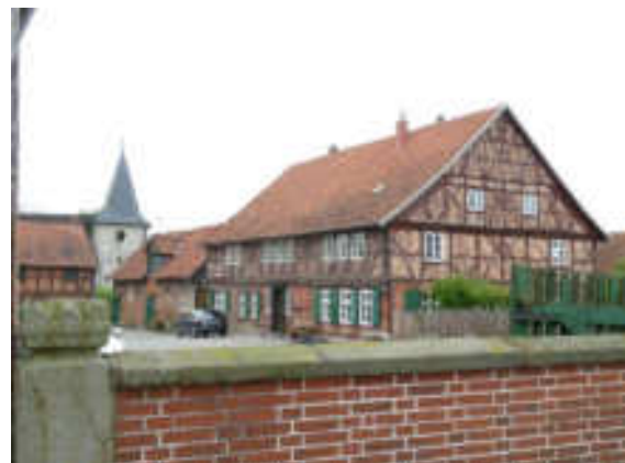
Beispielgebend für lang gestreckten rechteckigen Baukörper, Beispiel aus Steinlah
