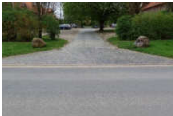
Vorbildlich erhaltenes Natursteinpflaster einer landwirtschaftlichen Hofstelle, Beispiel aus Groß Heere
