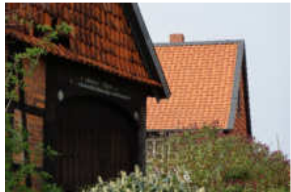
Giebelbehang (links) und Dacheindeckung mit Krempziegeln, Beispiele aus Haverlah
