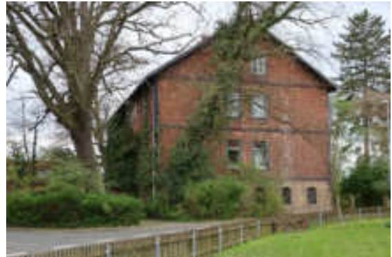
Ehemalige ortsbildprägende Groß Heerer Zigarrenfabrik
