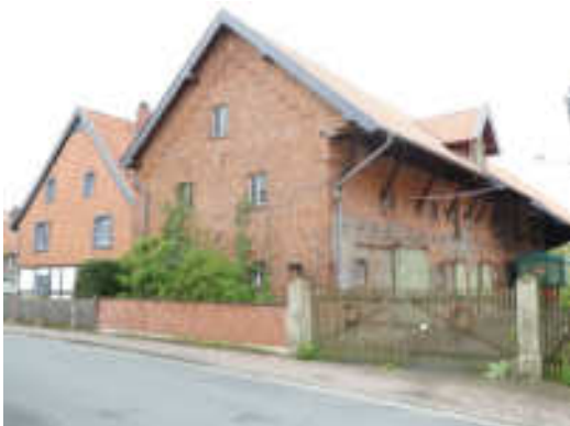
Wirtschaftsscheune mit Ziegelmauerwerk in Haverlah
