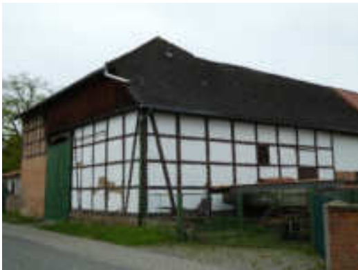
Erweiterter Wirtschaftsscheunenkomplex mit erhalten gebliebenem verputzten Lehmgefachen, Beispiel aus Steinlah
